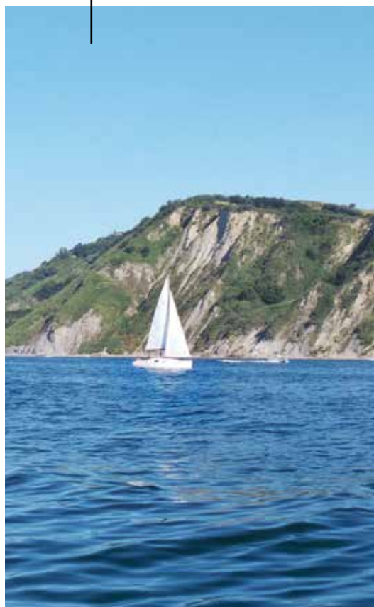
La falesia del Parco San Bartolo vista dal mare The cliff of St. Bartolo Park seen from the sea
